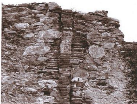
Mur de pedra amb fileres de totxanes que sostenien l'arrancada de les voltes de la capella.
